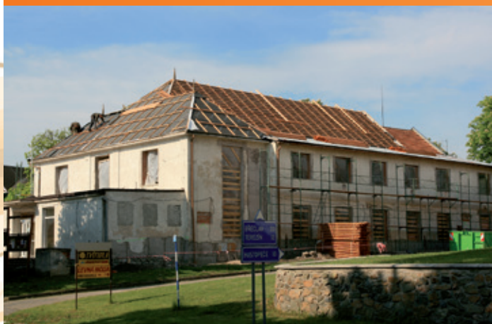
Rekonstrukce Sokolovny – pokládka střešní krytiny
