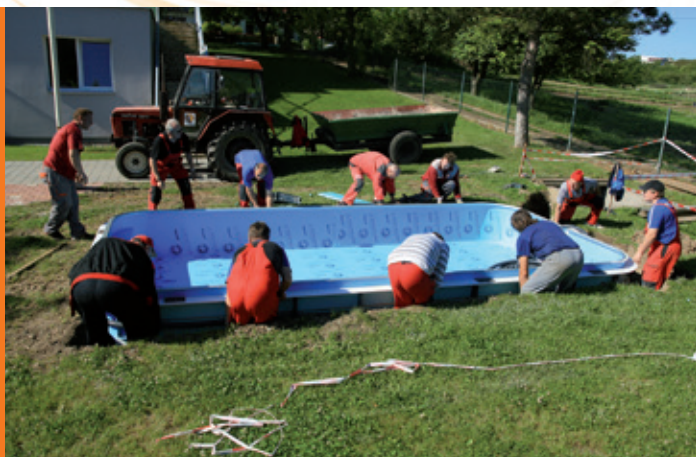
Mateřská škola – pokládání nového bazénu pro brouzdaliště
