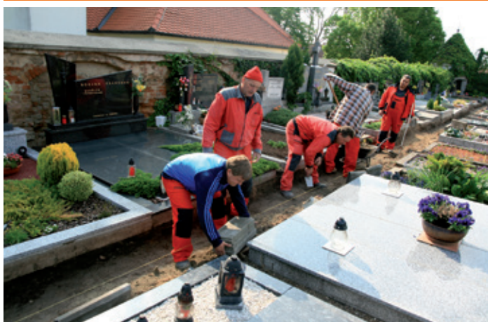
Oprava chodníků na hřbitově
