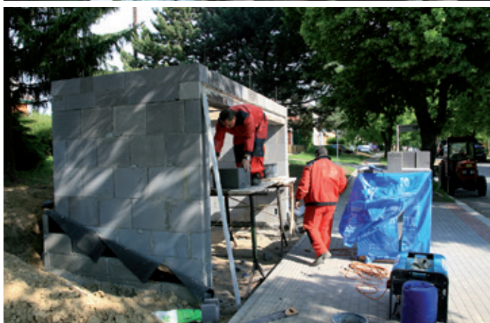
Stavba nové čekárny autobusové zastávky před obchodním domem COOP, ul. Hlavní
