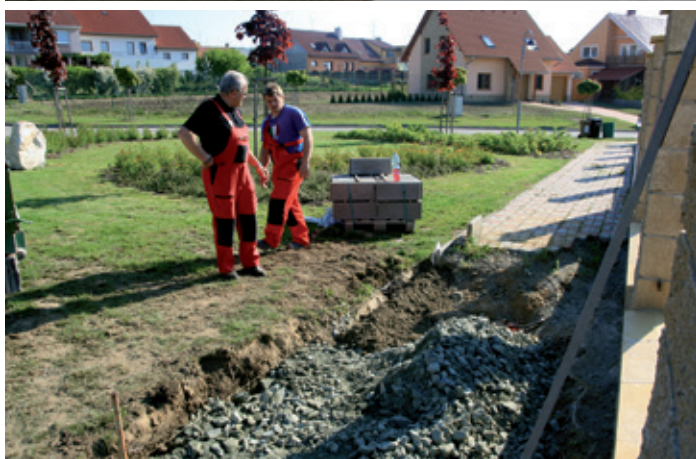
Budování chodníku v lokalitě Padělký, ul. Bří Mrštíků a Kopečky
